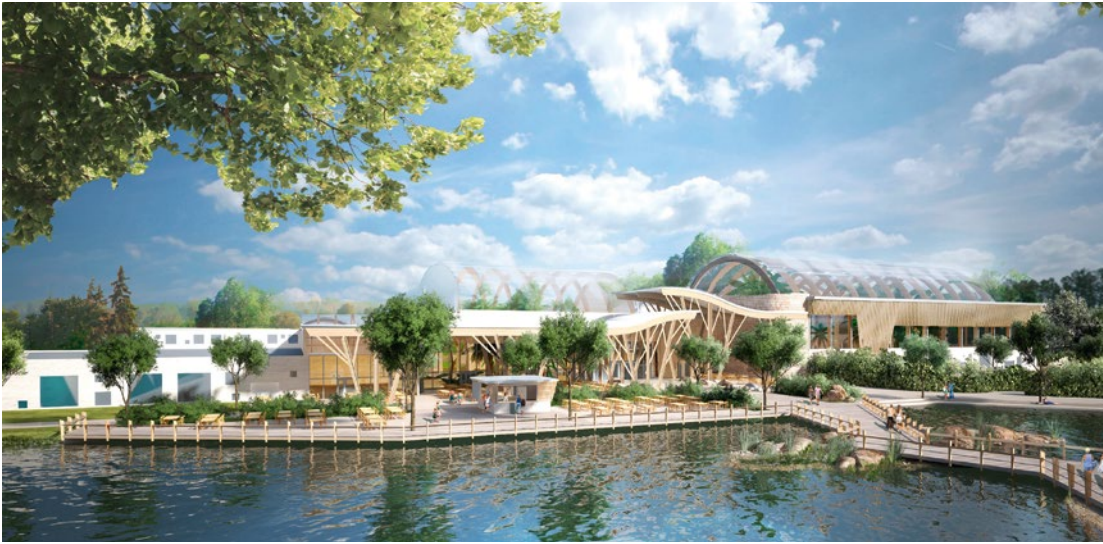
Die innovative Kalkschutz-Lösung überzeugte unter anderem die Betreiber des Center Parcs im Allgäu.
