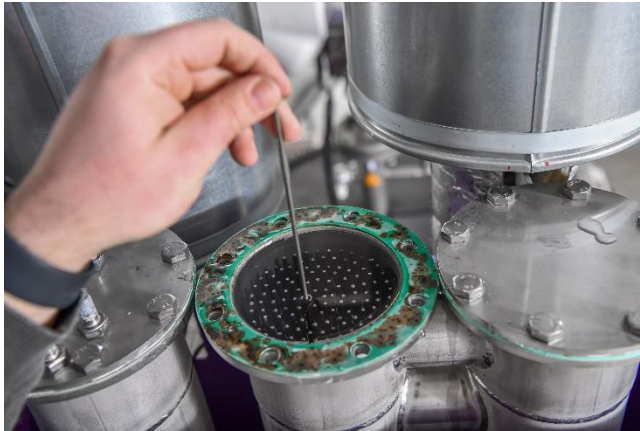
Bildunterschrift (2025_Kaufbeuren_00077_Web): Wirksamkeitsnachweis nach knapp einem Jahr Praxisbetrieb: Blick in den komplett kalkfreien Rohrbündel-Wärmetauscher.
