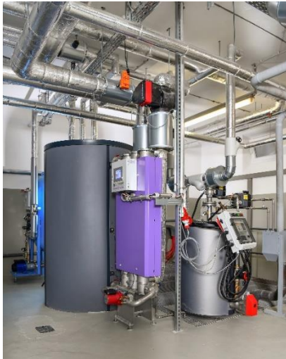
Bildunterschrift (2025_Kaufbeuren_00008_Web): Kompakt und übersichtlich, aber ausgesprochen wirkungsvoll: die Kalkschutzanlage BIOCAT 11000" (re.), daneben der Wärmetauscher für PWH sowie der 1.000 l-Pufferspeicher.
