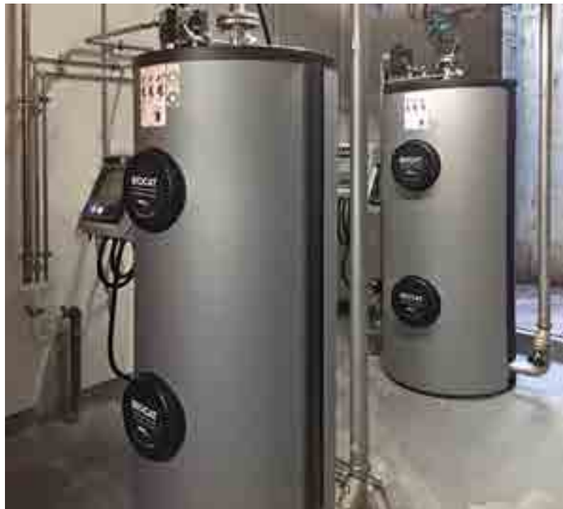
Die chemiefreie Kalkschutzanlage Biocat KS 5D liefert wirksamen Schutz vor Kalksteinbildung für einen maximalen Tagesverbrauch von 50.000 l
